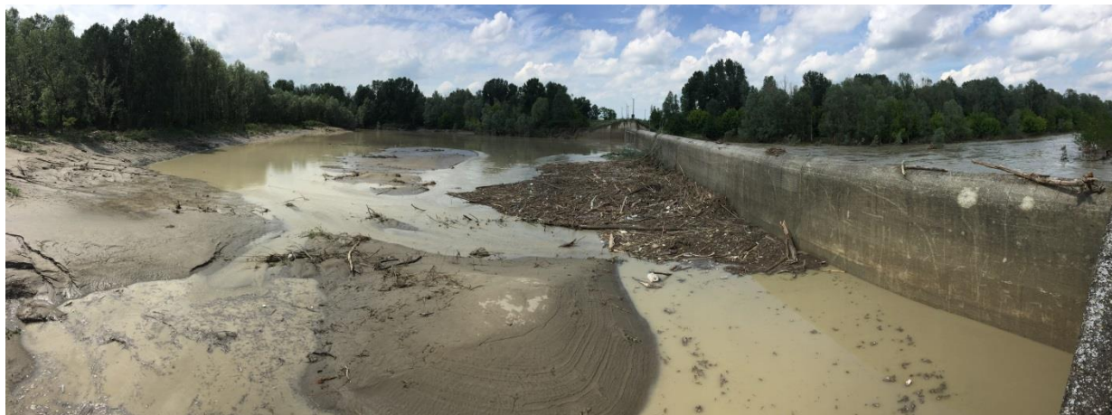
Figura. 163. Cassa di espansione sul F. Secchia: accumulo e completa ostruzione luci n°1+2 (da sponda destra) [28.05.2019].
