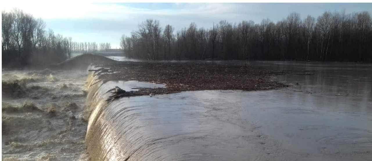
Figura. 160. Cassa di espansione sul F. Secchia: sfioro su manufatto regolatore [02.02.2019].
