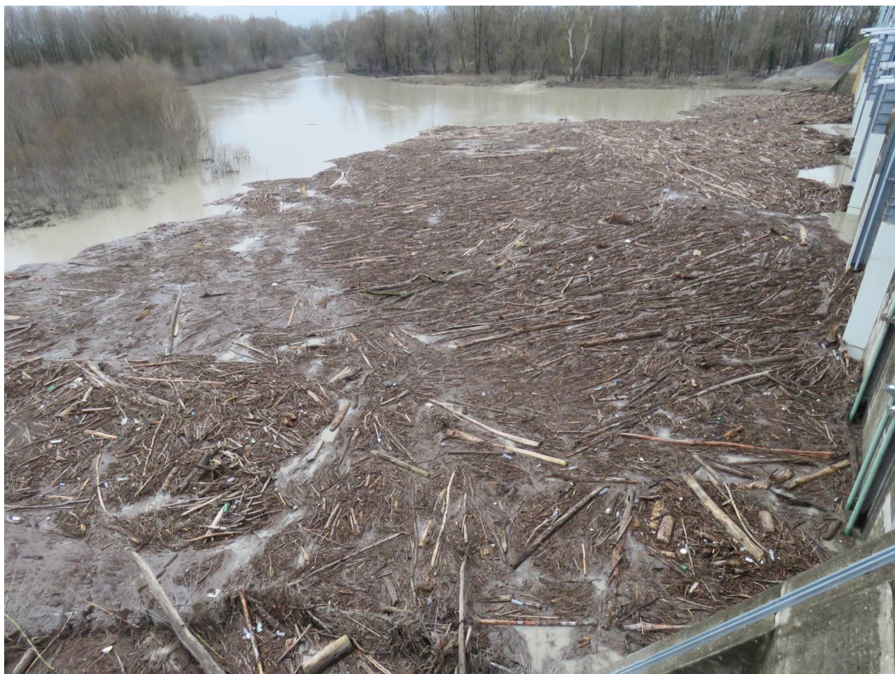
Figura. 165. Ostruzione di paratoie per il deposito di materiale legnoso.
