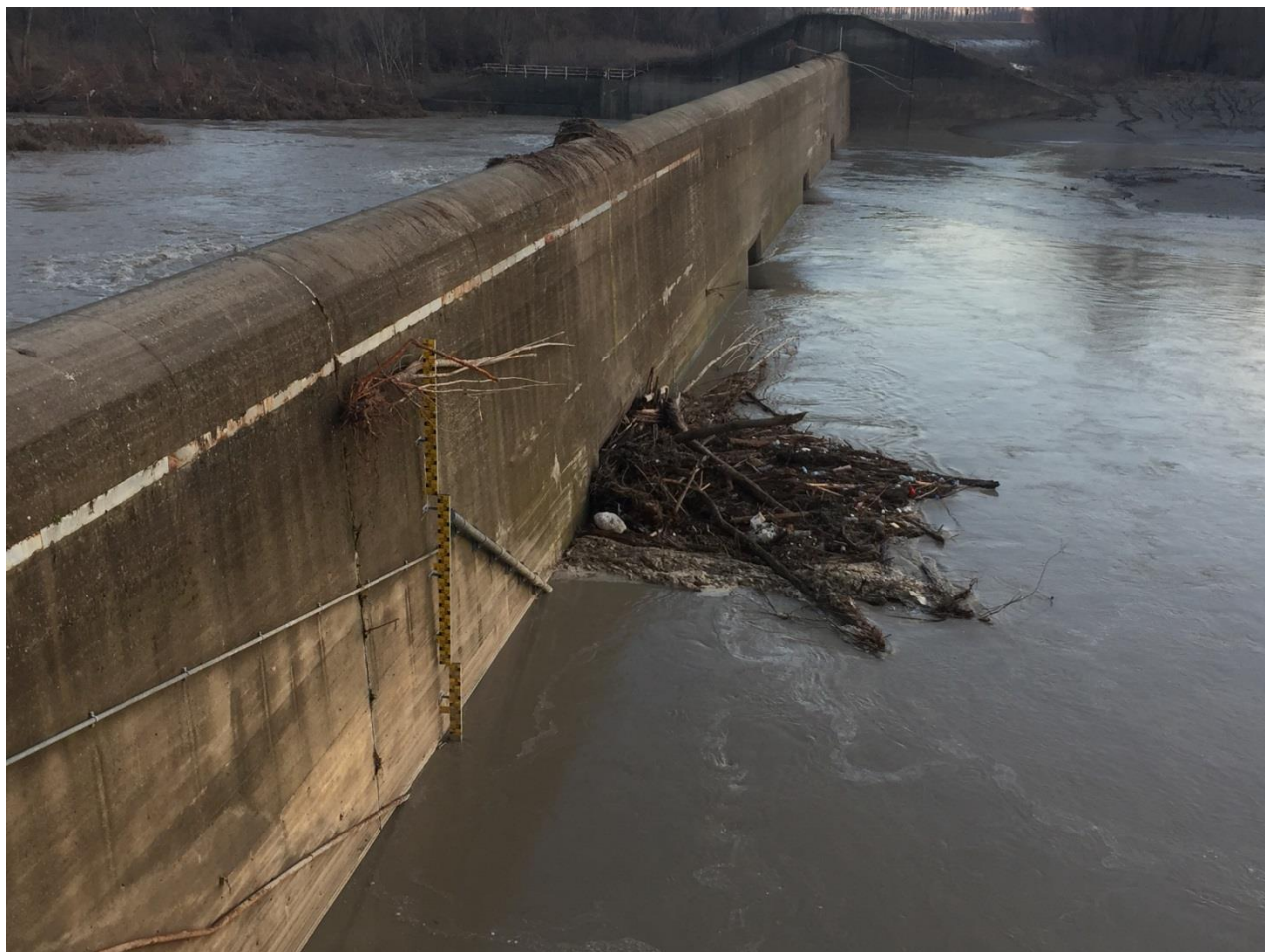
Figura. 160. Cassa di espansione sul F. Secchia: sfioro su manufatto regolatore [02.02.2019].
