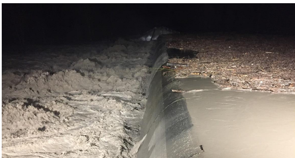
Figura. 158. Cassa di espansione sul F. Secchia: inizio sfioro su manufatto regolatore [12.12.2017].
