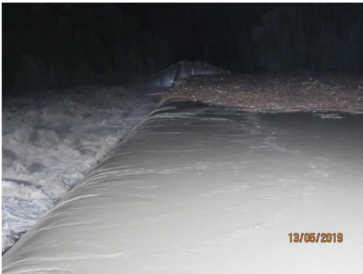
Figura. 162. Cassa di espansione sul F. Secchia: accumulo e completa ostruzione luci n°1+2 (da sponda destra) [14.05.2019].
