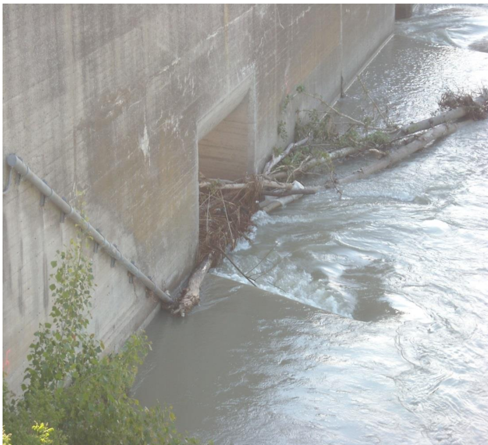
Figura. 158. Cassa di espansione sul F. Secchia: inizio sfioro su manufatto regolatore [12.12.2017].
