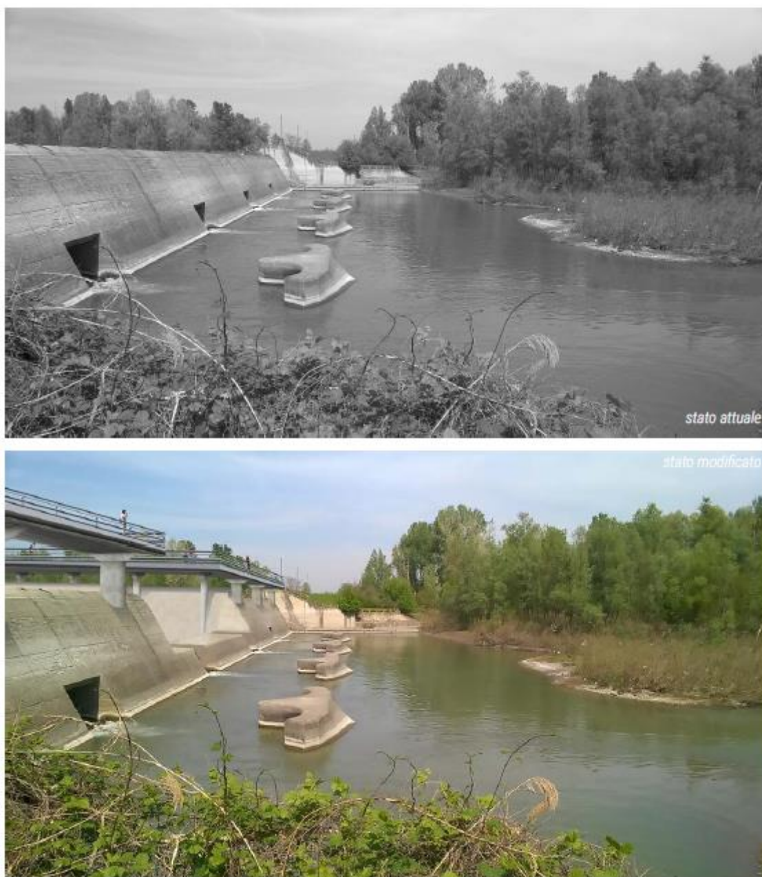
Figura 296: Simulazione n.1 – stato attuale e di progetto a confronto del manufatto regolatore.
