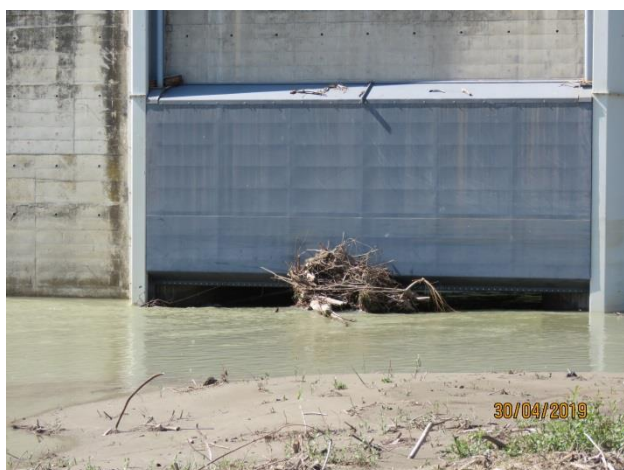
Figura. 165. Ostruzione di paratoie per il deposito di materiale legnoso.
