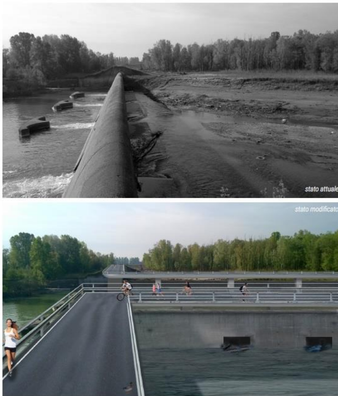
Figura 297: Simulazione n.2 – stato attuale e di progetto a confronto del manufatto regolatore, con dettaglio del nuovo percorso di servizio sopraelevato.
